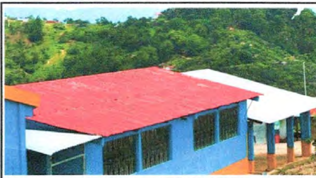
Foto 2: Mantenimiento a cubierta de lámina (aplicación de pintura anticorrosiva)
