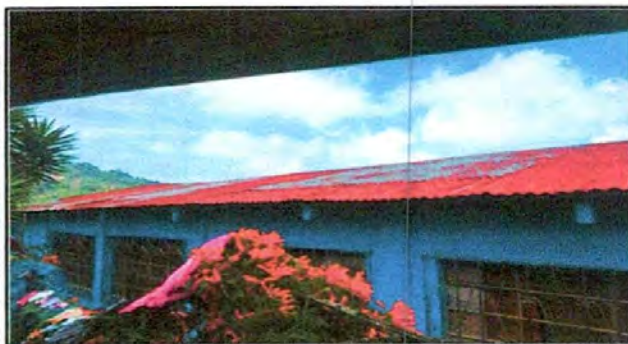
Foto 5: Sustitución de canales
