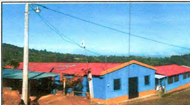
Foto 1: Sustitución del techo de lámina
