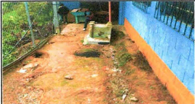
Foto 10: Reparación de losa de concreto
