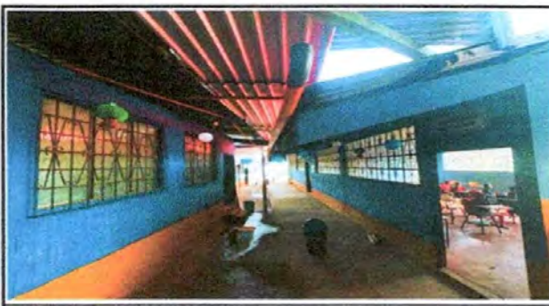
Foto 6: Sustitución de canales
