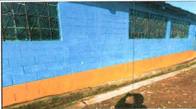
Foto 7: Aplicación de pintura en muros exteriores
