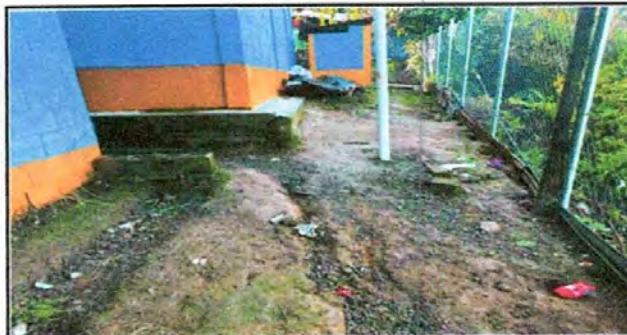
Foto 9: Reparación de losa de concreto
