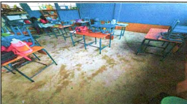
Foto 4: Sustitución de piso
