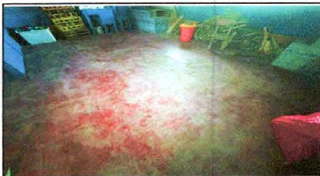
Foto 3: Sustitución del piso de torta de concreto.
