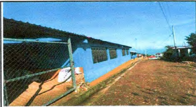
Foto 8: Aplicación de pintura en muros exteriores
