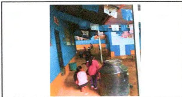
Foto 12: Sustitución de depósito de agua 1700lt
